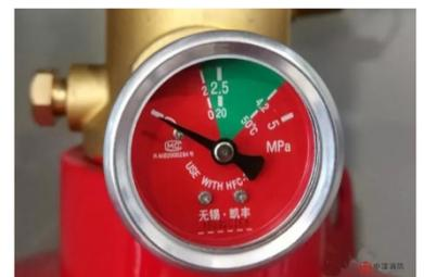
(5) 二酸化炭素消火設備の消火剤が、設計上の貯蔵量の10%以上漏洩しているが、適切なメンテナンスが行われていない。
