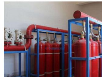
(4) 消火剤ボンベと駆動窒素ガス貯蔵容器内の圧力が不足し、メンテナンスも実施されていない（圧力計の針が適正範囲から外れている）
