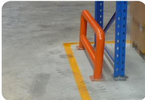
衝突防止用のフェンスに変形の痕跡があった場合、フォークリフトの運転速度が速いことが一因と推測できます。このような状況で、万が一ラックと激突すると、運搬中の貨物や、ラックに保管されている貨物に損失を与える可能性があります。
