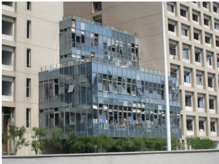
【③（写真左および下）：全側面の窓ガラス・窓枠が破損した建物】水濡れ防止等の応急処置もされていないように見受けられる。 （爆発地点から約 1,100m）
