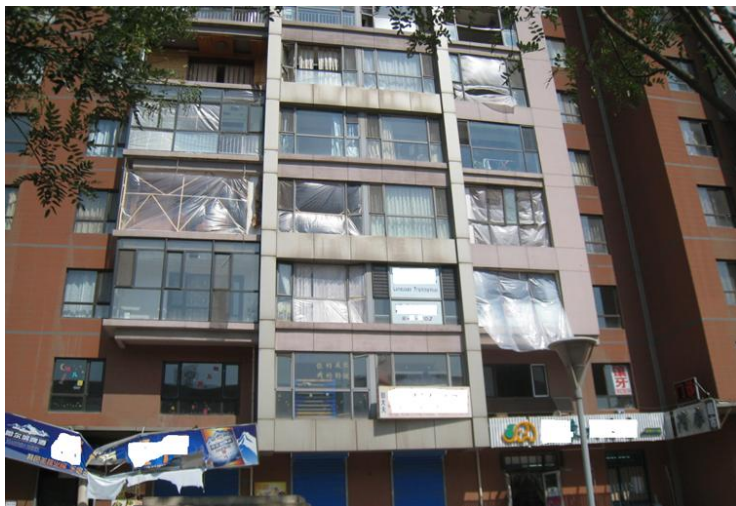
【①（写真左）：ショッピングモール前のマンション】窓はシート等で仮補修されている（爆発地点から約 1,900m）
