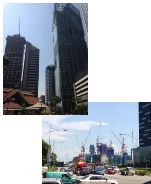
【図1】シンガポール弊社入居ビル周辺の建設工事現場（筆者撮影）
