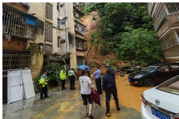
図11 広西省梧州市の山崩れ現場の状況 (出典: 梧州市自然資源局)
