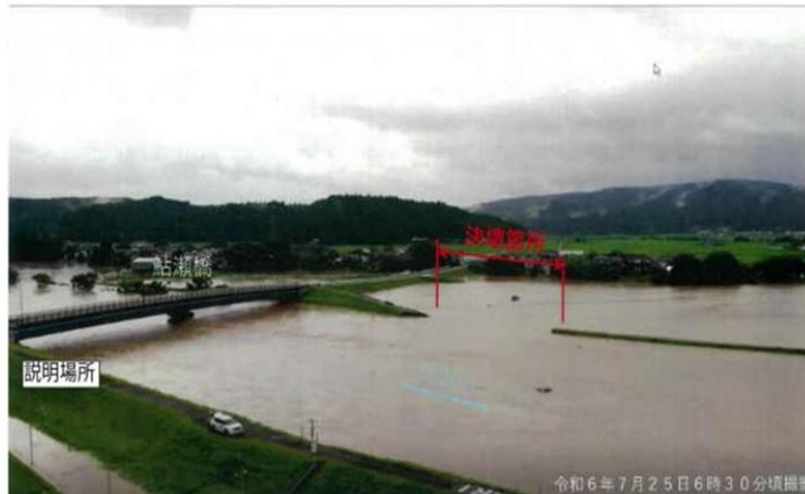
【図6】子吉川水系石沢川の堤防決壊の様子 決壊延長 60m（秋田河川国道事務所<sup>6)</sup>）
