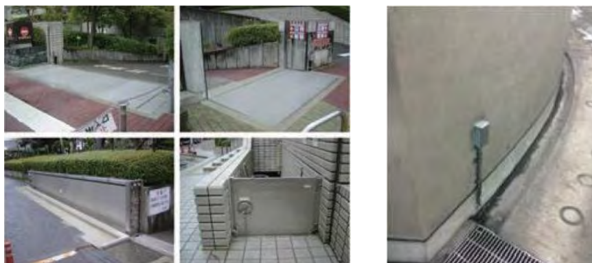
【写真 1】止水板設置事例
