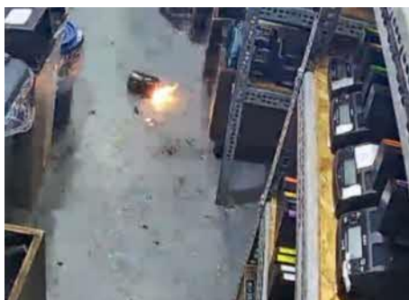
充電していたカメラ用バッテリーからの出火状況 (防犯カメラ映像)
