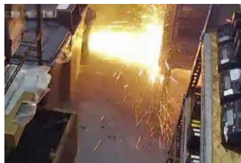
火炎が噴出している状況 (防犯カメラ映像)
