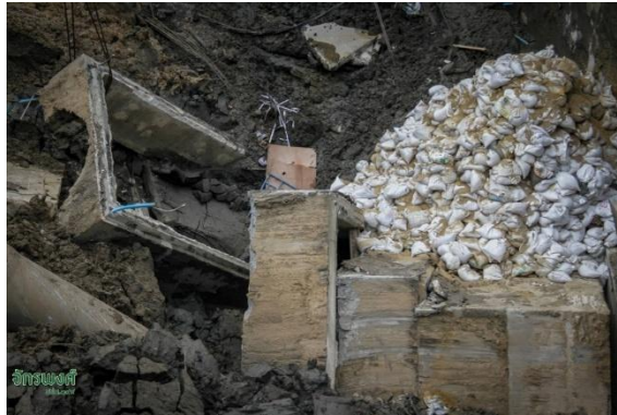
土のうによるトンネルの密閉 (参考:Facebook: Office of Disaster Prevention and Mitigation)
