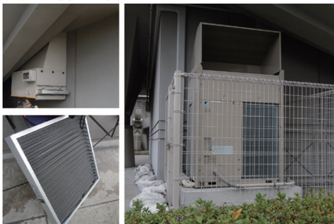
【図1】桜島の降灰に備えた空調機器の対策の例 (竹中工務店調査資料)
