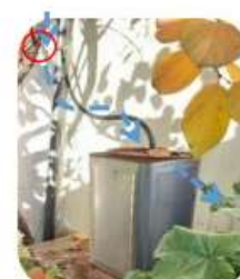
雨樋→ホース→斗缶の接続 (赤丸は雨樋切れ目部分)
