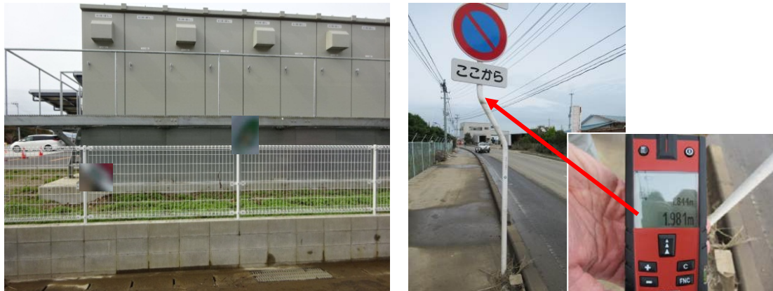
左：高所設置により水没を免れた屋外キュービクル、右：付近の浸水痕と浸水深の測定値
