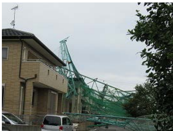
フェンスの倒壊による住宅の被害（市原市）
