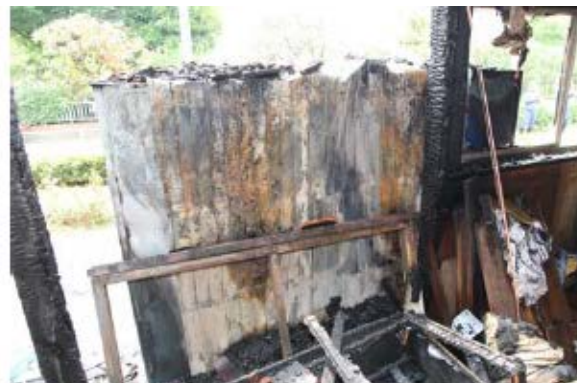
自動販売機の裏面の状況
