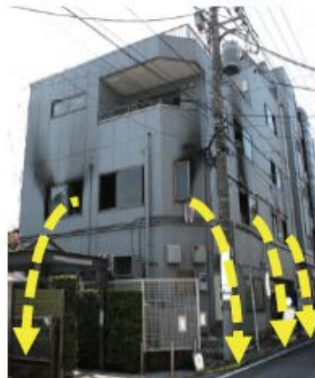
飛び降り避難の状況
