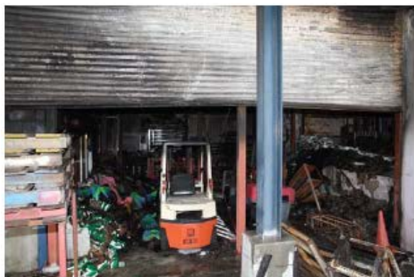
資材倉庫内部の状況
